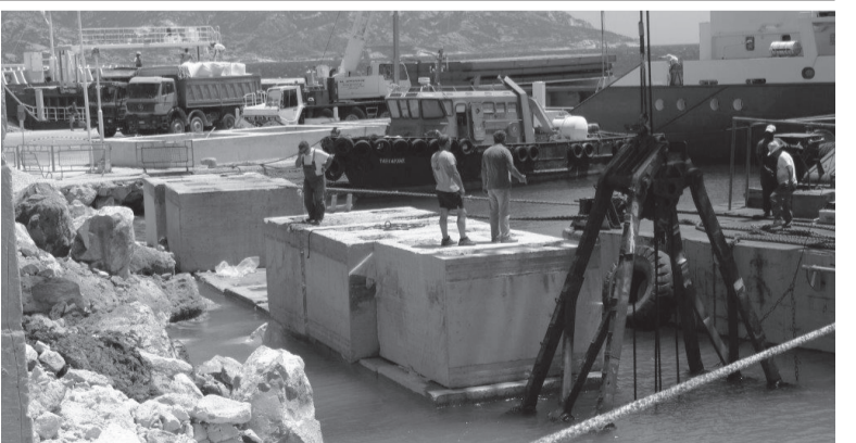
Τα λιμενικά έργα στη Ψάθη σε πλήρη εξέλιξη
